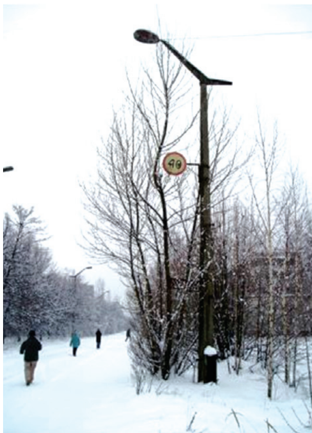
Figura 13.1. Iluminat stradal tipic (sursa: Sabre Roads)
