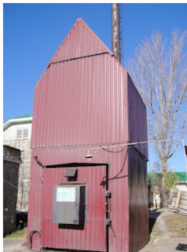
Figura 21.1. Cazan pe bază de paie amplasat în satul Antonești, Moldova (sursa, TimothyHornsby.blogspot.com)
