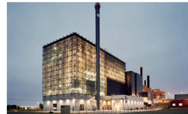
Figura 17.4. CET modernă de incinerare a deșeurilor în apropiere de Linköping, Suedia. Capacitatea este de circa 24 tone de deșeurii pe oră, 65 MW energie termică pentru SACET și 19 MW energie electrică. (sursa: Usital)
