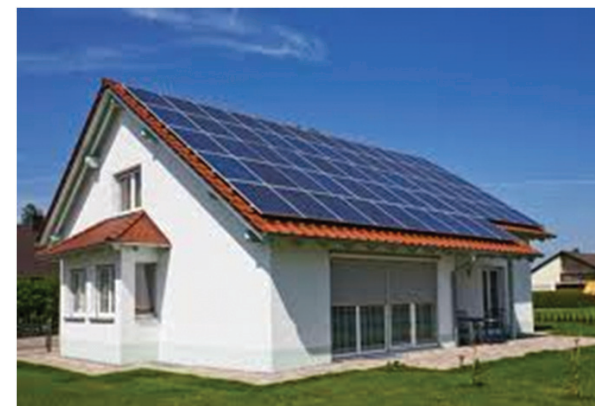
Figura 16.2. Sistem rezidențial fotovoltaic cu module cristaline. Capacitatea sistemului este de aproximativ 12 kW și ar produce 13.000 kWh anual (sursa: http://energyinformative.org/blog ).
