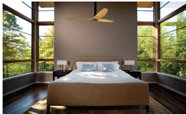
Figura 10.5. În funcție de amplasare, acest ventilator de tavan fabricat de Haiku consumă doar de la 2 la 30W (sursa: Haiku)
