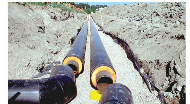
Figura 5.4. Instalarea rețelelor termice moderne (sursa: www.aldaberg.se).
